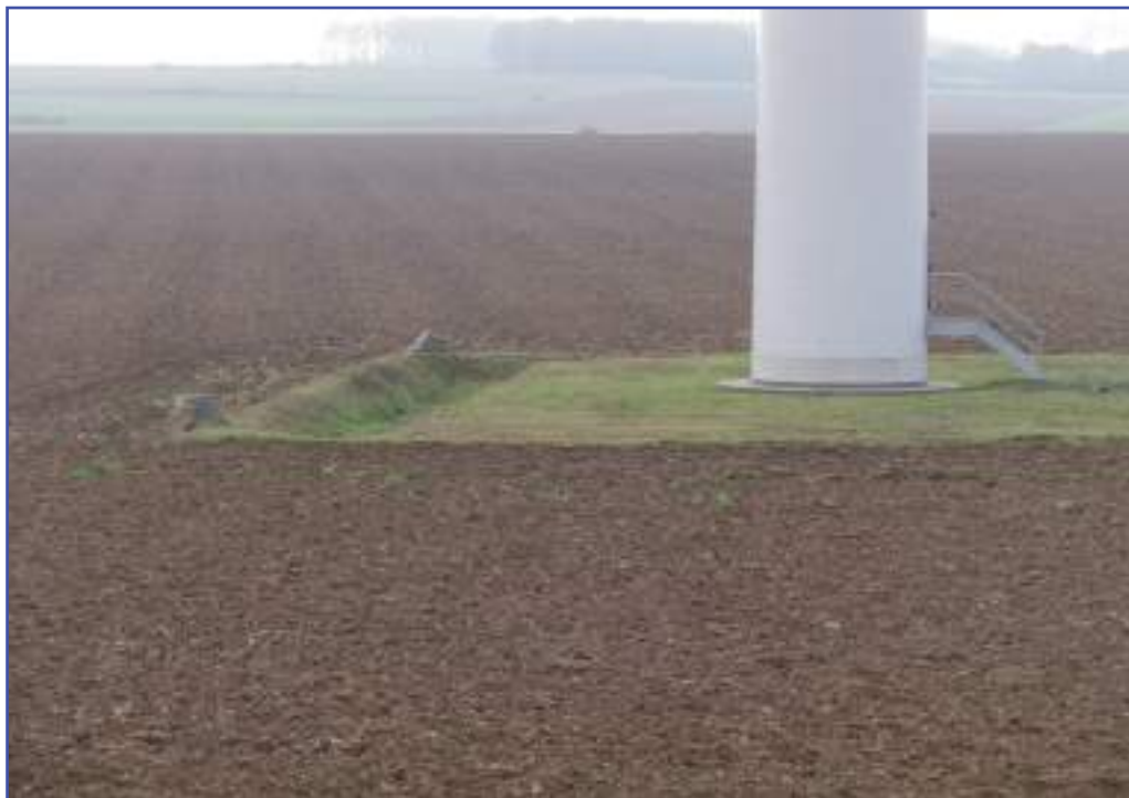
Photo 6 : Exemple de noue en limite de plate-forme
